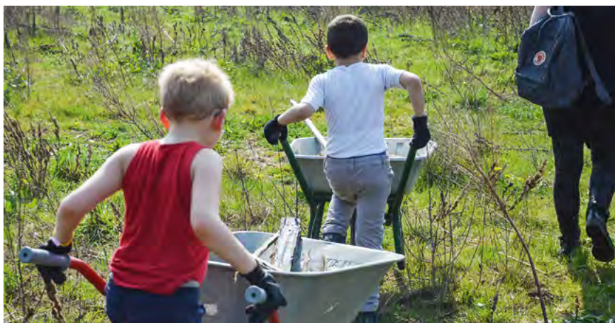
Kinder helfen bei der Bauausführung im NER mit (Quartiersmanagement Heerstraße/Thomas Streicher)
